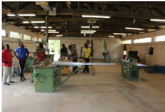
Die renovierte Schreinerei mit LED Beleuchtung
